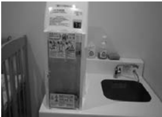
写真 3-2-3-4 ミルクを作る給湯設備
